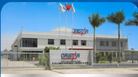
Nhà máy số 2 tại TP. Hồ Chí Minh: Diện tích 10.000m 2 Factory No. 2 in Ho Chi Minh Total Area: 10,000 m 2
